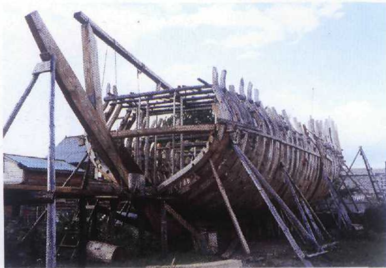
Wrzesień 1996 - widoczny już kształt kuźtuba
