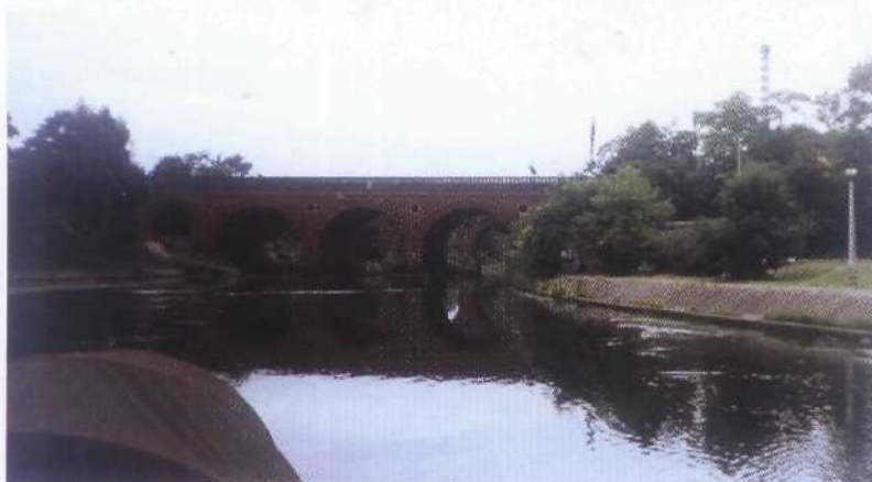
Ceglane mosty kolejowe na Brdzie w Bydgoszczy. Choć zaniedbane, przypominają czasy świetności Kanału Bydgoskiego
