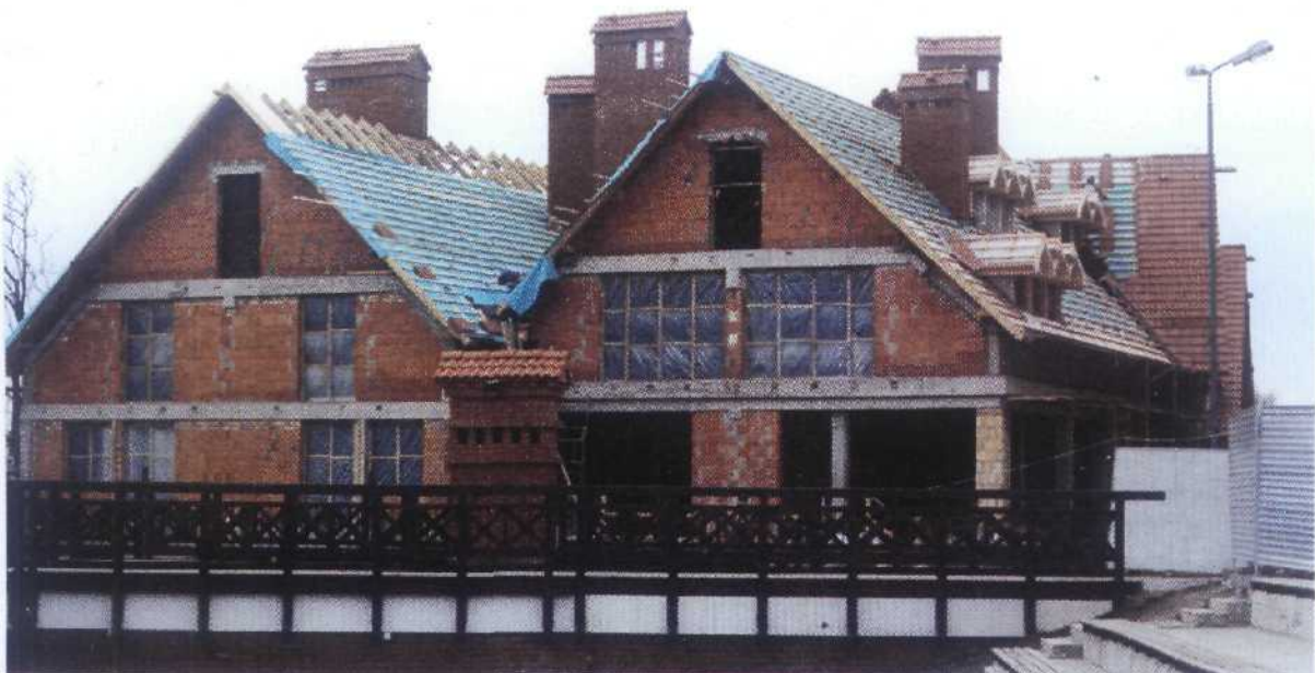
„Bulwar” w trakcie budowy - widok od strony amfiteatru
