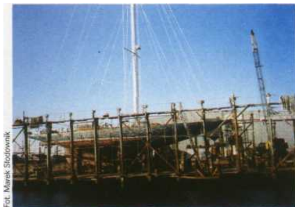
Podczas prac remontowych
